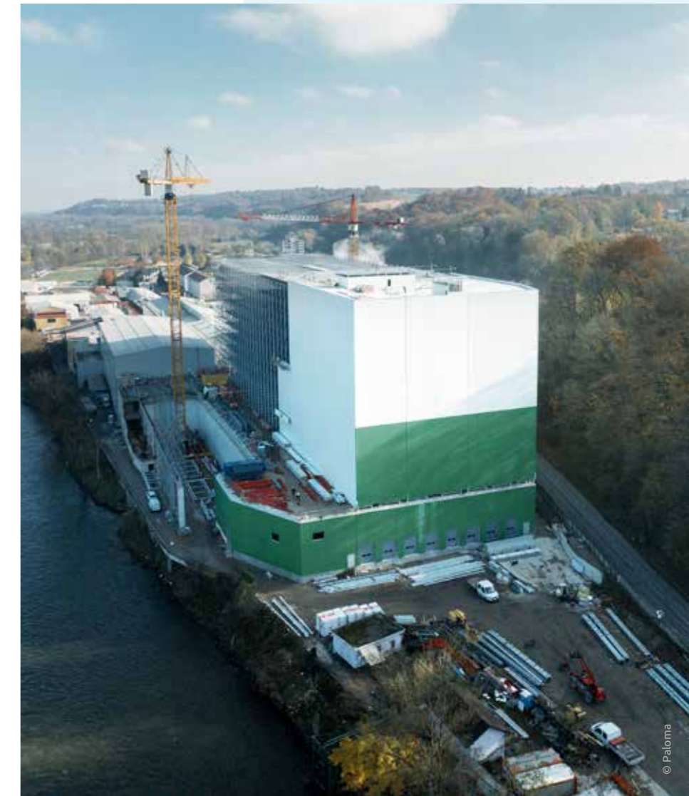
Anspruchsvoll wie genial: ECE-LOG errichtet das neue Lager direkt auf der neu gebauten Produktionshalle. Sophisticated and ingenious: ECE-LOG builds the new warehouse on top of the newly constructed production hall.
