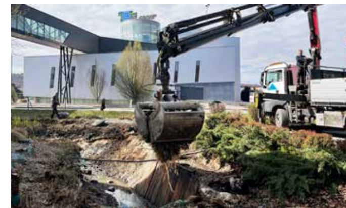
30 Tonnen Folien und Schilfwurzeln wurden mit Hilfe eines LKW-Greifers entfernt. 30 tons of foils and reed roots were removed with the help of a truck gripper.
