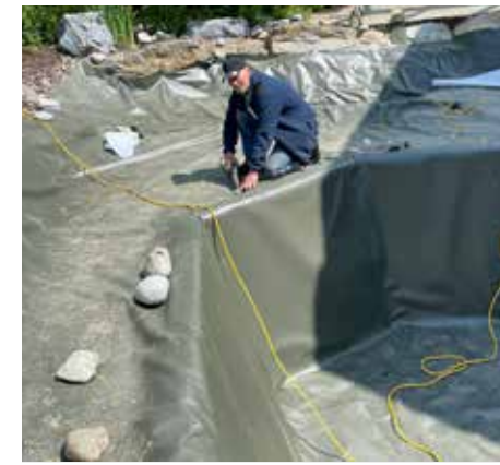
Folienerlegung durch den Teichfolienfachmann Gerhard Kasper. Foil installation by the pond foil specialist Gerhard Kasper.
