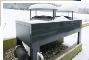
Technikraum und Wärmepumpe Technology room and heat pump
