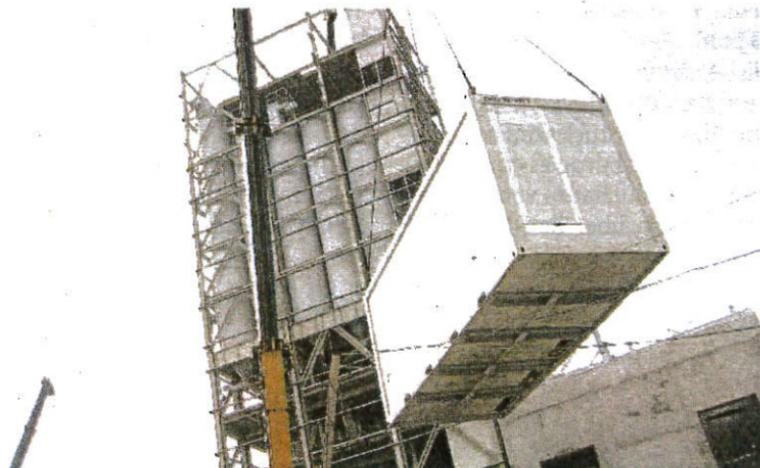
Die „Siemens Sivacon S8“ ist als Containerausbau erhältlich und daher einfach zu einen anderen Standort zu transportieren.
