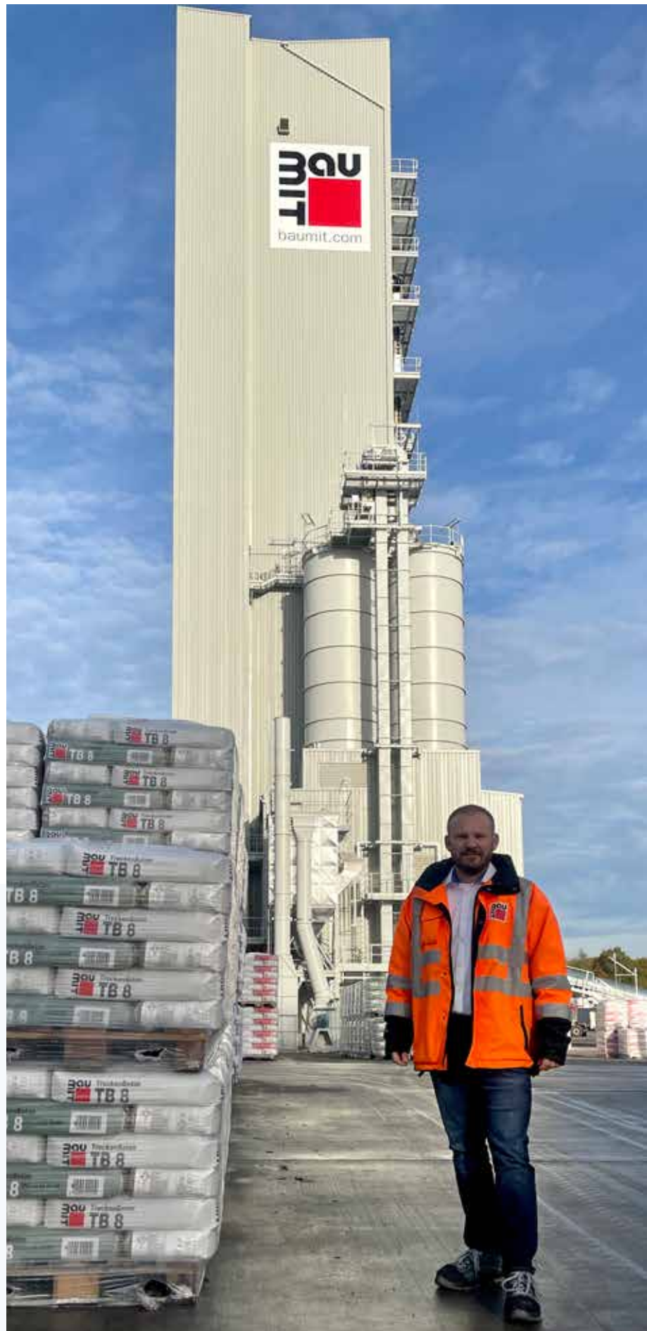
Oliver Bothe Werksleiter von Baumit vor der neuen Mischanlage
