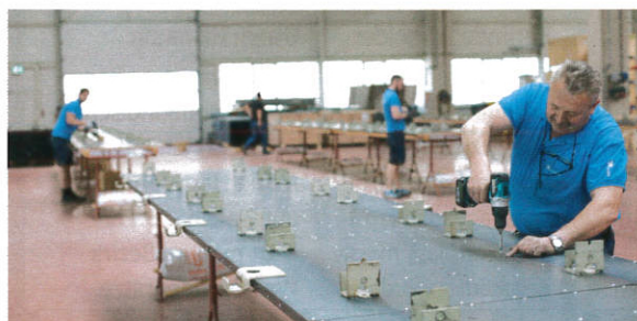
In Brodingberg entstand die neue Assembling-Halle.
