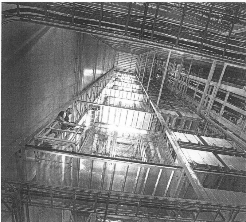
Ein Blick von unten in das neue Hochregallager für Rohtabak: Insgesamt 32 Meter ist es hoch und kann bis zu 27 000 Tonnen Tabak, in Kartons verpackt, lagern. TV-FOTO, JTI
